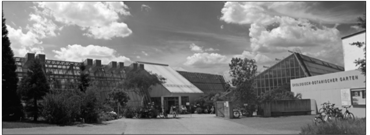
Seit 30 Jahren stehen sie gut da: Die Tropengewächshäuser sind das Herzstück des ÖBG.
